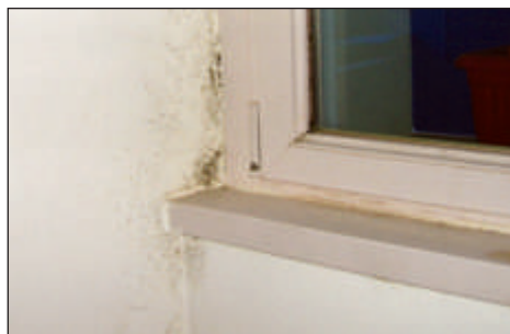
Esempio di ponte termico morfologico in prossimità del contorno telaio finestra.
