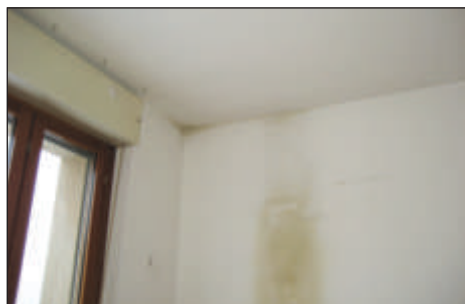
Esempio di ponte termico strutturale in corrispondenza del pilastro e della trave.
